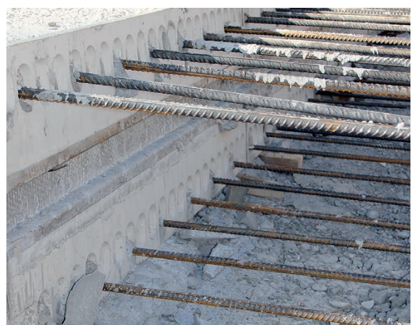
Spital Limmattal, Schlieren ZEMBORD WD-I in Bodenplatte (ohne Injektions- schlauch)
