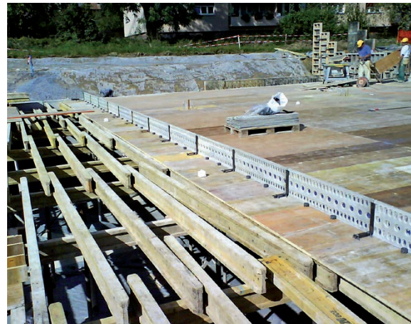
WÜB Bettlach 50 m ZEMBORD in 30 Minuten verlegt
