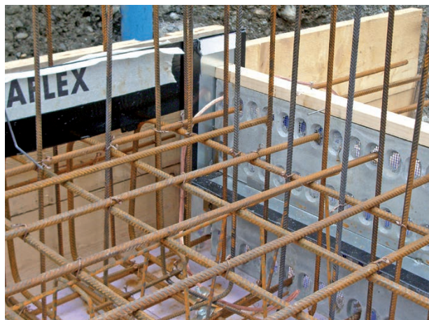
Wasserdichte Arbeitsfugen, z.B. mit Pentaflex
