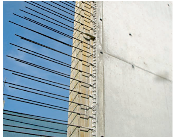
Migros, Neuendorf ZEMBORD als Wand-Abschalelement eingesetzt
